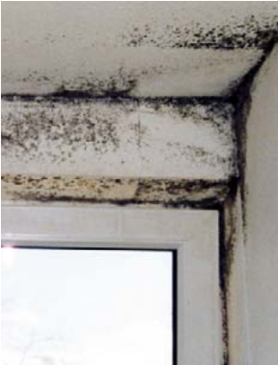
Die Folge eines ständig gekippten Fensters.
