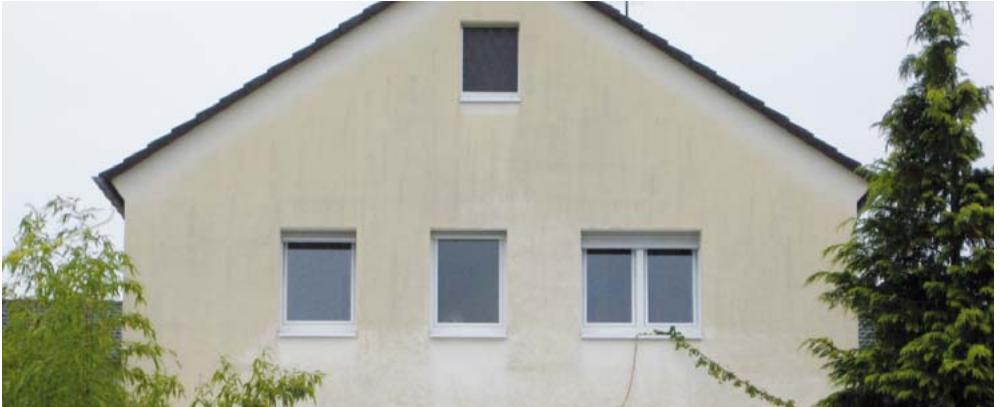
Der Verzicht auf eine wasserabweisende Fassadenbeschichtung kann ursächlich für Schimmel im Innenbereich sein.
